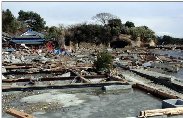
2011年3月 震災直後の浦戸地区 家屋は流され土台だけ
